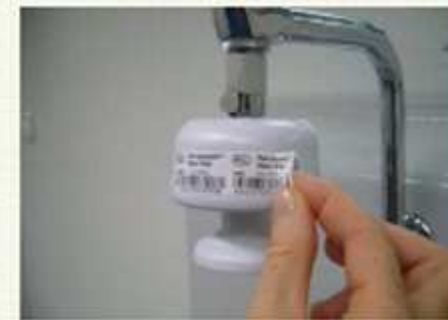
Décoller l'étiquette détachable et la placer sur le document de traçabilité si utilisé puis noter la date de pose et de retrait sur l'étiquette restée sur le filtre
