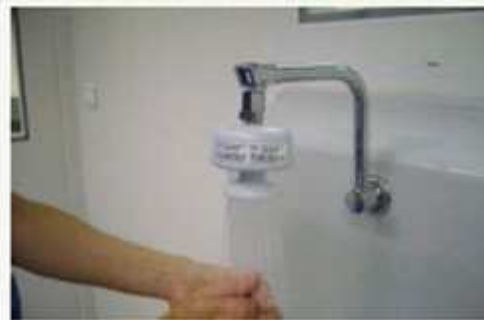
Vérifier l'absence de fuite au niveau du raccord en faisant couler l'eau
